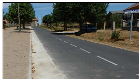
Recuperación de camiños e accesos (San Vitoiro)
